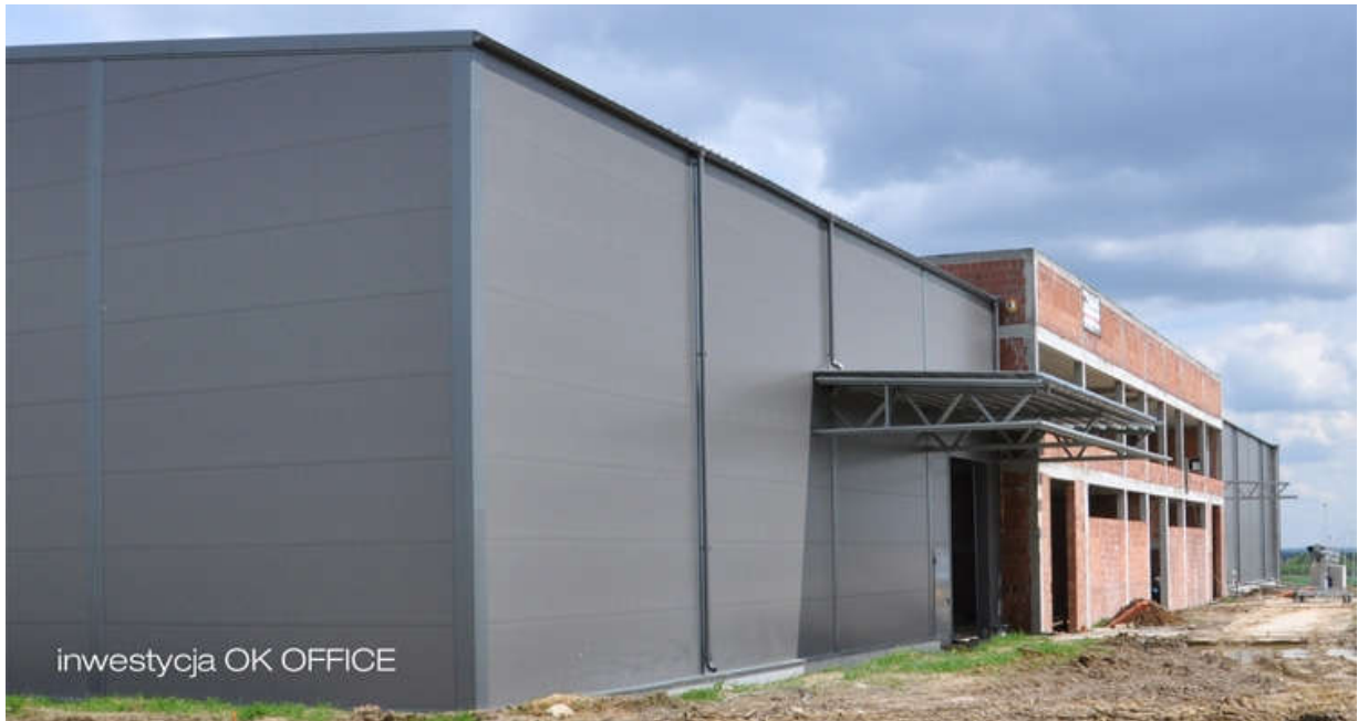
Fabryka Ok Office Rączy w trakcie budowy. Fot. PN-T "Rzeszów-Dworzysko"
